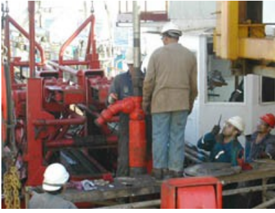
Les mesures en puits... 3 jours et 3 nuits de travail en continu
