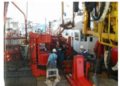
la plateforme de forage
